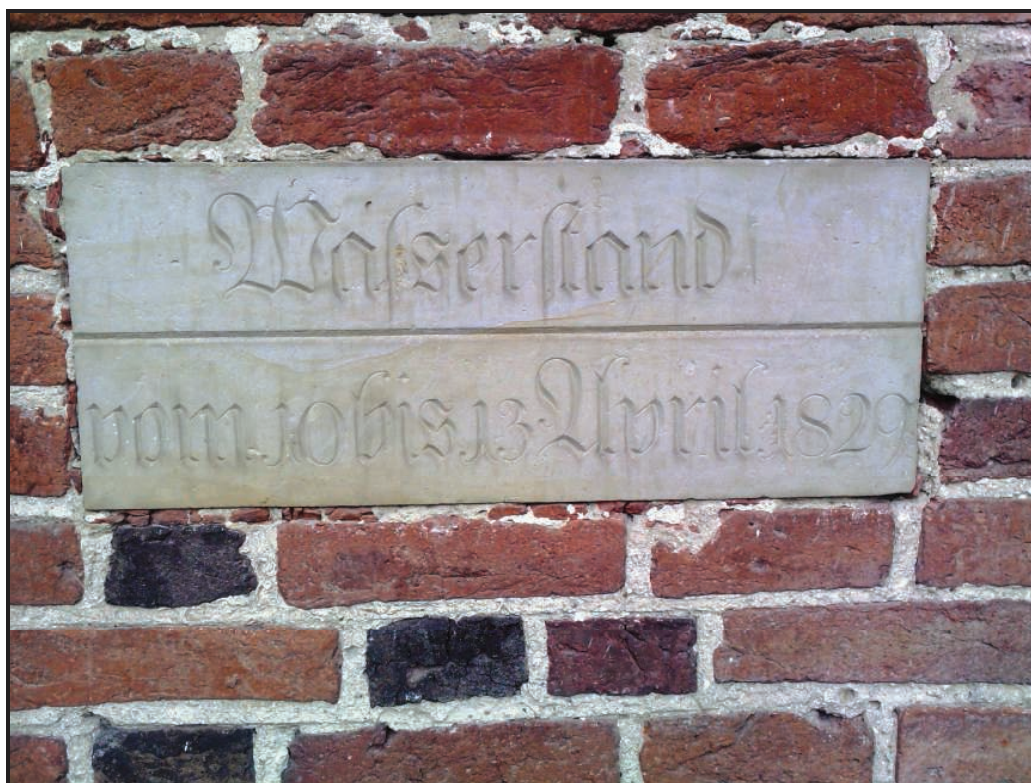
Fot. 22. Znak wielkiej wody Wasserstand von 10 bis 13 April 1829 umieszczony na ścianie kościoła w Trutnowach (4.06.2009)
