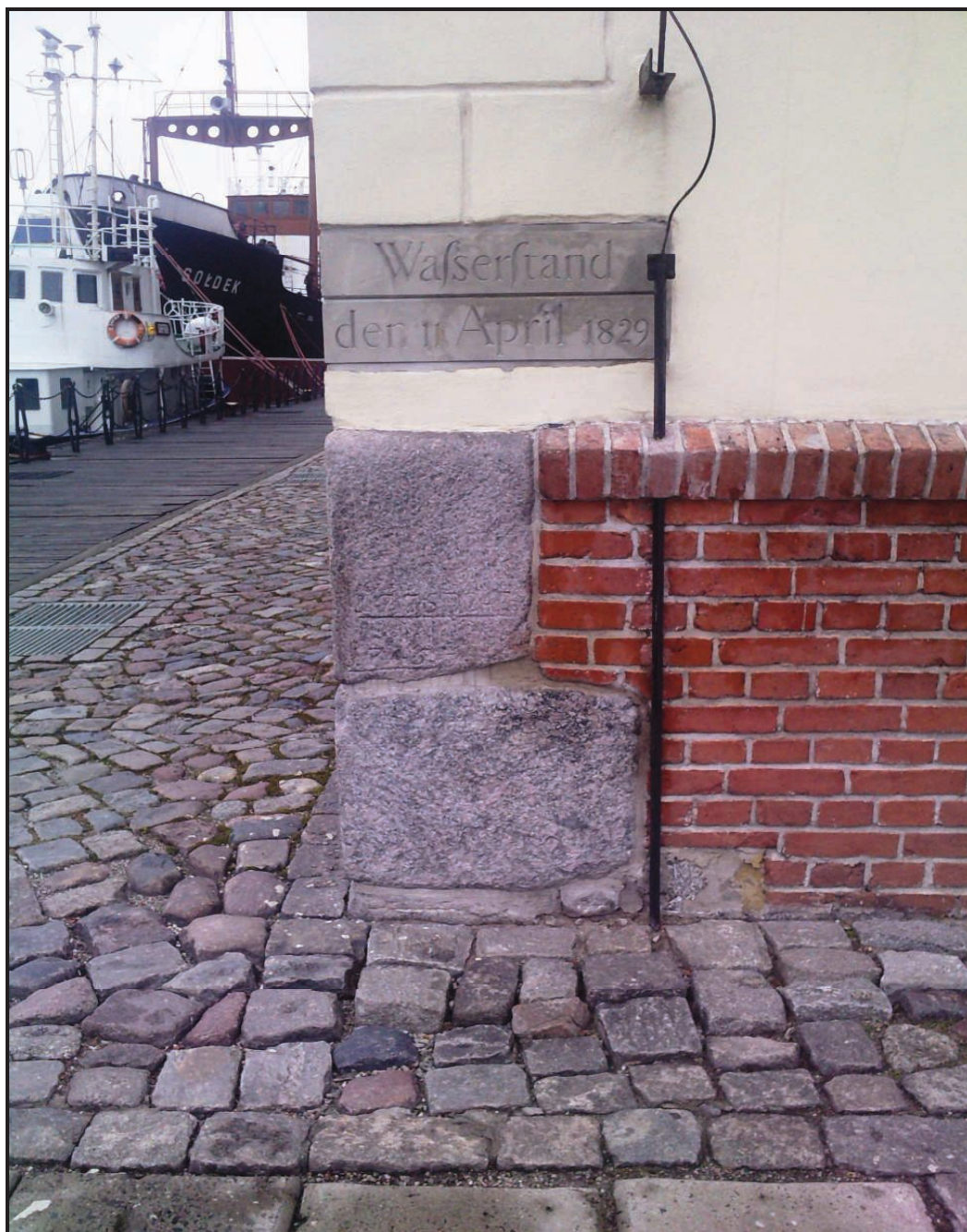
Fot. 16. Znaki wielkiej wody 1745, 1775 D 24 Fe, 11.IV.1829 umieszczone na Spichrzu Panna w Gdańsku (4.06.2009)
