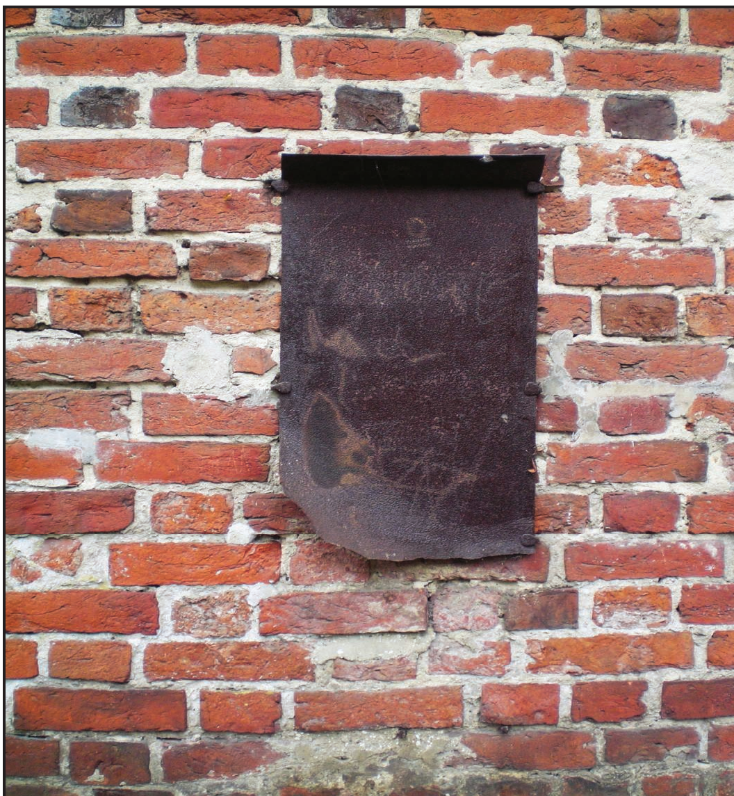
Fot. 12. Tablica powodziowa umieszczona na wschodniej ścianie kościoła pw. Podwyższenia Krzyża Świętego w Myszewie (8.06.2009)
