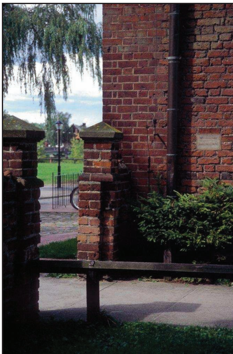
Fot. 6. ZWW 25.III.1888 r. umieszczony na kościele pod wezwaniem Św. Wawrzyńca (8.06.2009)
