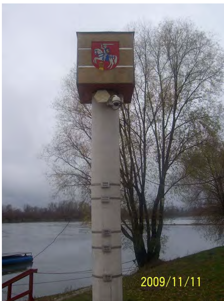
Fot.19 Słup znajdujący się na bulwarze wiślanym w Puławach z zaznaczonymi odtworzonymi stanami wody (11.11.2009).
