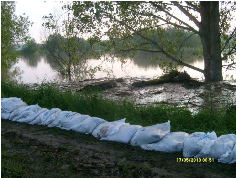
Fot.21 Umocniony wał przeciwpowodziowy w Kępie Gosteckiej (19.05.2010), fot. P. Dziechciarz
