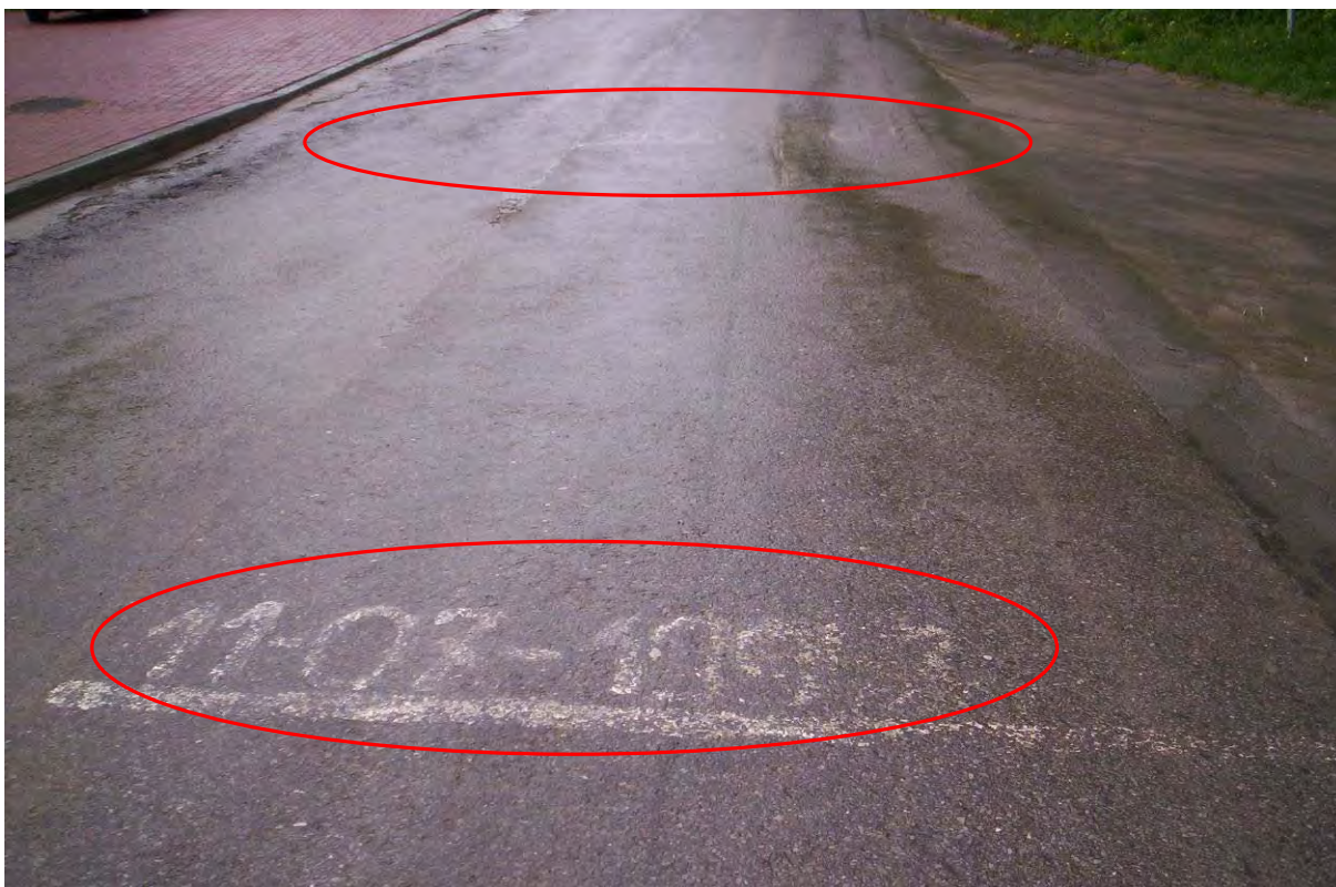
Fot.18 Droga dojazdowa do promu w Zawichoście, z zaznaczonym zasięgiem wód powodziowych z lipca 1997 roku i lipca 2001 roku (01.05.2010).
