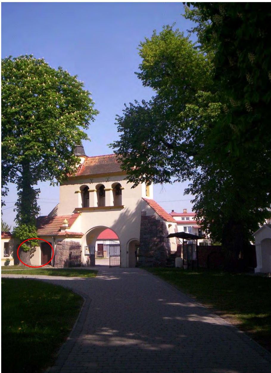
Fot.12 Widok od strony kościoła na bramę kościelną w Wilkowie wraz z zaznaczonym znakiem (02.05.2009).
